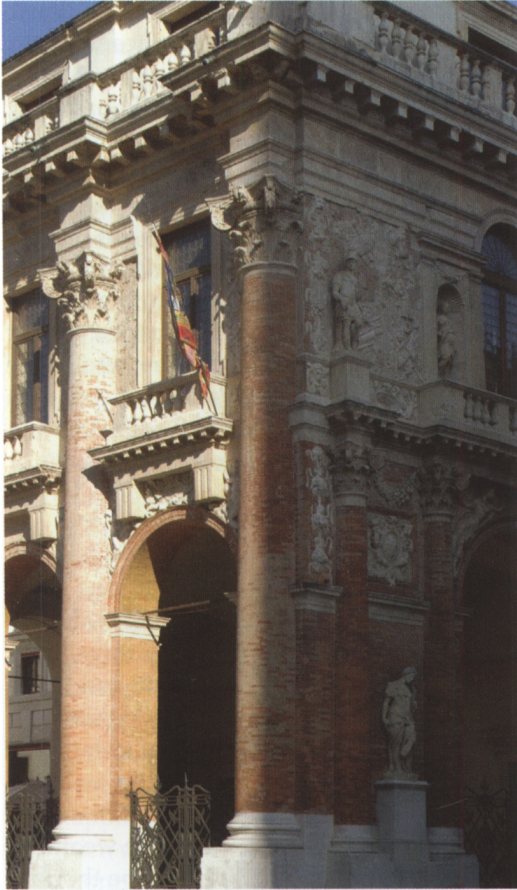
Fig. 21. Palladio's Composite order: façade and side of the Loggia del Capitaniato, Vicenza
