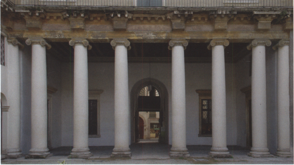
Fig. 12. Palladio's Ionic order: courtyard portico of Palazzo Valmarana, Vicenza
